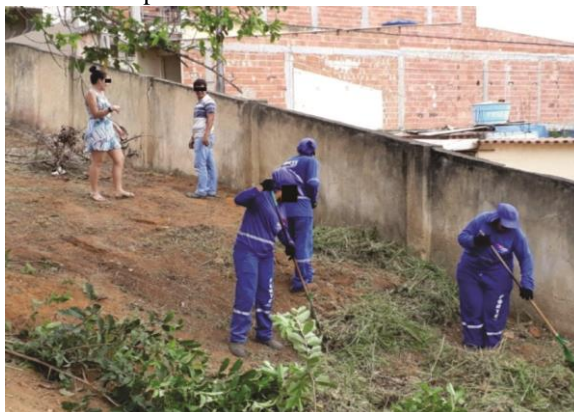
Foto 1: Limpeza do terreno
