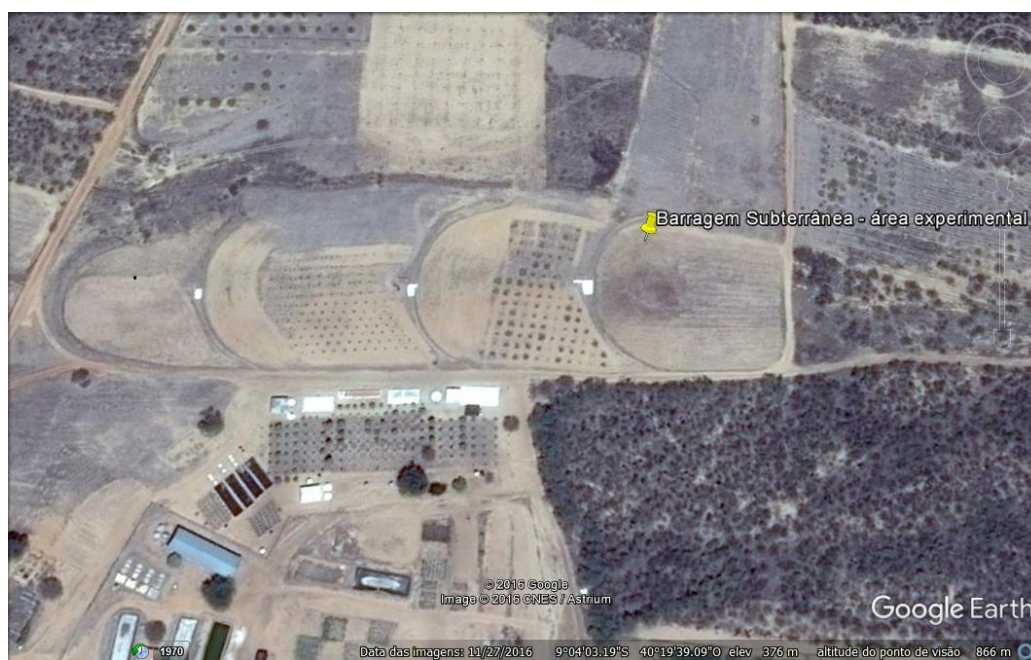
Figura 1. Vista aérea da barragem subterrânea na Embrapa Semiárido, Petrolina – PE.
