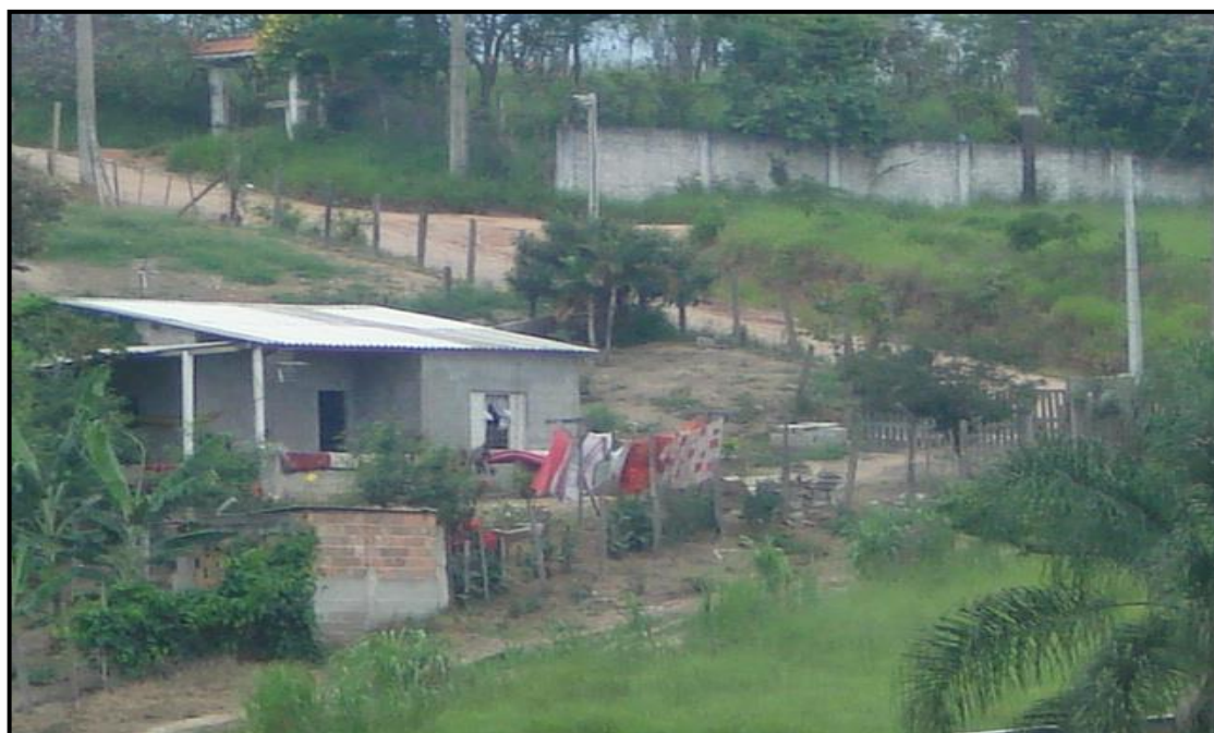
Figura 6: aspecto construtivo do local - Bairro Veraneio Ijal Data 30/05/2012
